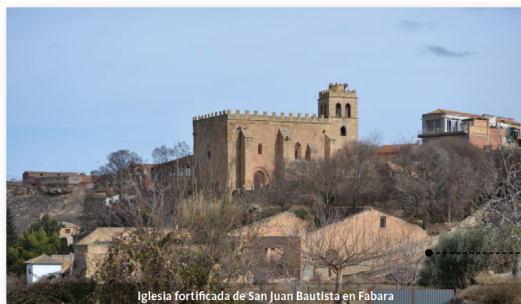
Iglesia fortificada de San Juan Bautista en Fabara
