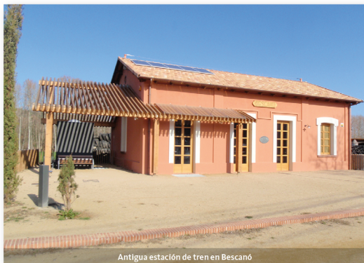
Antigua estación de tren en Bescanó
