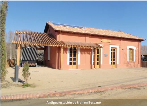
Antigua estación de tren en Bescanó
